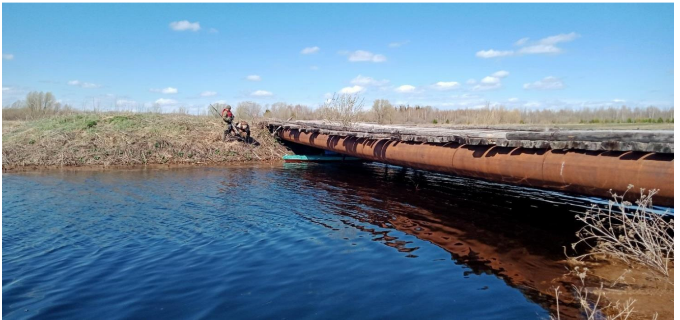
Фото 12. Трубный мост (37,7 км).
