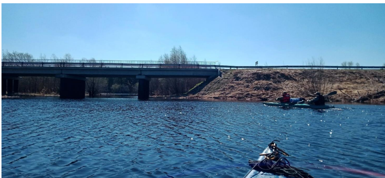
Фото 11. Между опорами автодорожных мостов плавень не задерживается.
